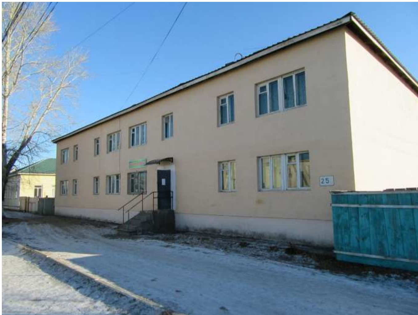
Фото 1. Общий вид обследуемого здания
